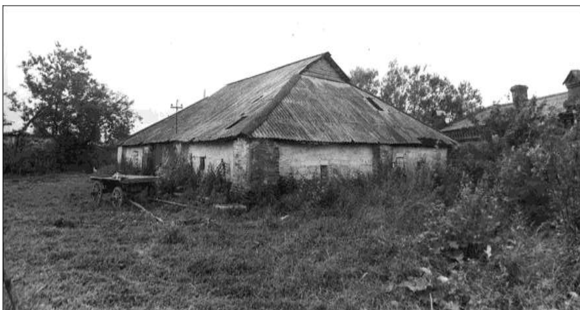
Комплекс центральной части деревни, XIX - начало XX вв., конюшня, общий вид с северо-запада (фото 1980 г.).
